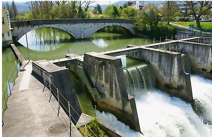
Durch eine Lockerung der Vorschriften im Umwelt- und Landschaftsschutz könnten vermehrt Kleinwasserkraftwerke gebaut werden. ZVG
